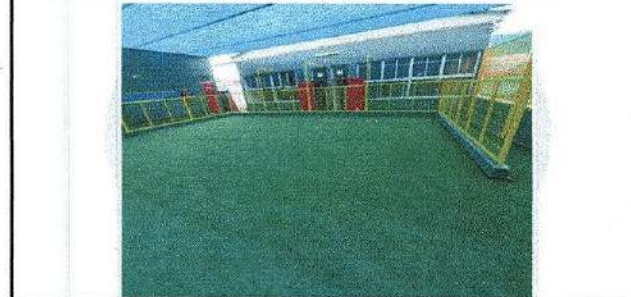
INSTALACIÓN DE REFUERZOS METÁLICOS EN MALLA ACMA DE BARANDAS DE SEGURIDAD EN PATIO PRE-BÁSICA.
