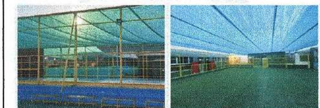
CAMBIO DE MALLA RASCHEL EN SOMBREADERO MULTICANCHA, PATIO PRE-BÁSICA Y SECTOR RIOSCO.
